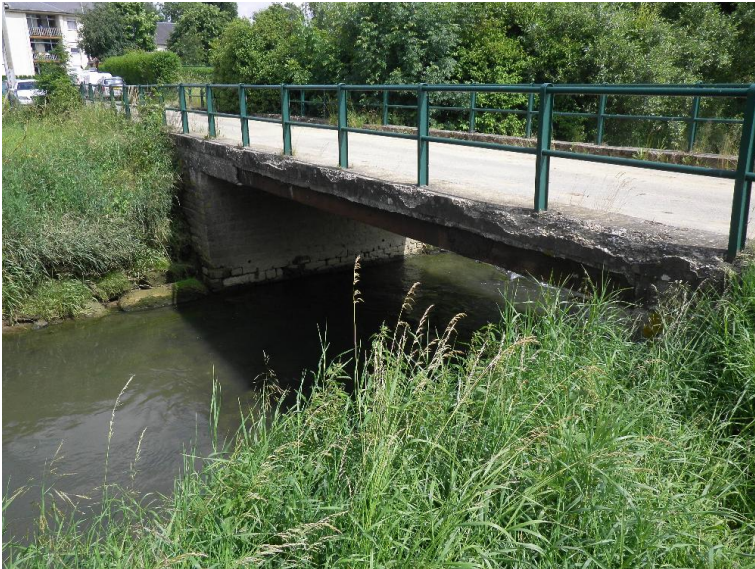
Durchlass; Ufer unterbrochen
