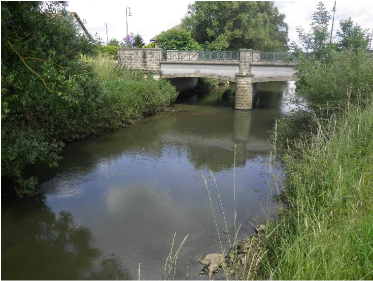
Durchlass; Ufer unterbrochen
