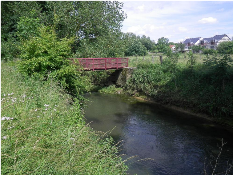
Durchlass; Ufer unterbrochen
