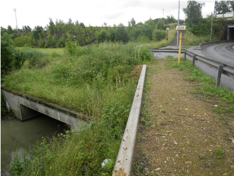
verrohrt bzw. ueberdeckt
