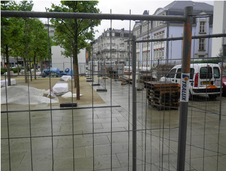
verrohrt bzw. ueberdeckt
