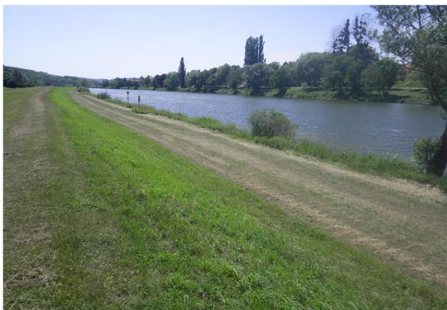
Foto gegen Fließrichtung
