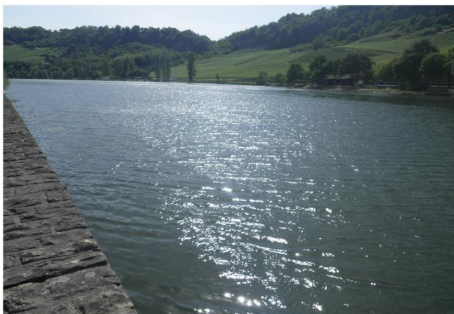
Foto gegen Fließrichtung
