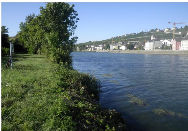
Foto gegen Fließrichtung
