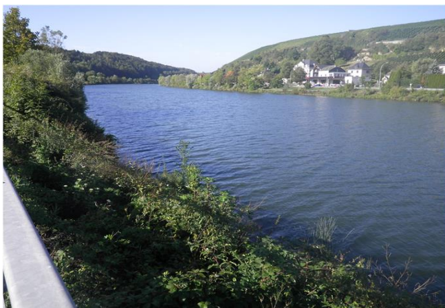
Foto gegen Fließrichtung
