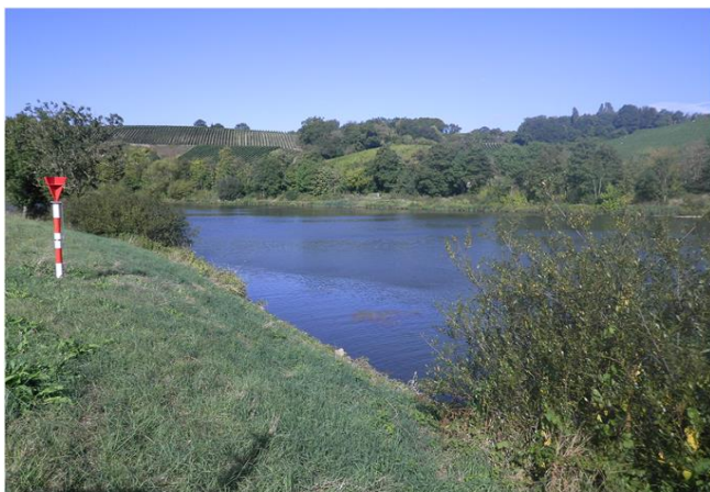
Foto gegen Fließrichtung
