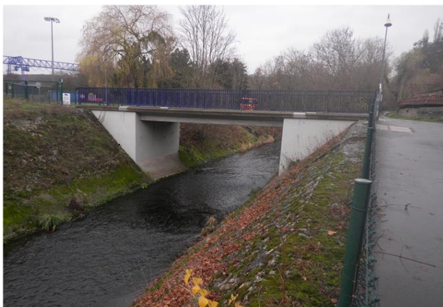
Foto gegen Fließrichtung
