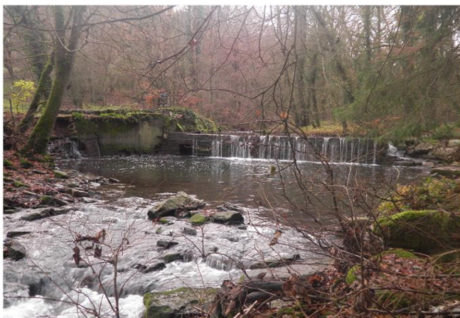
Foto gegen Fließrichtung
