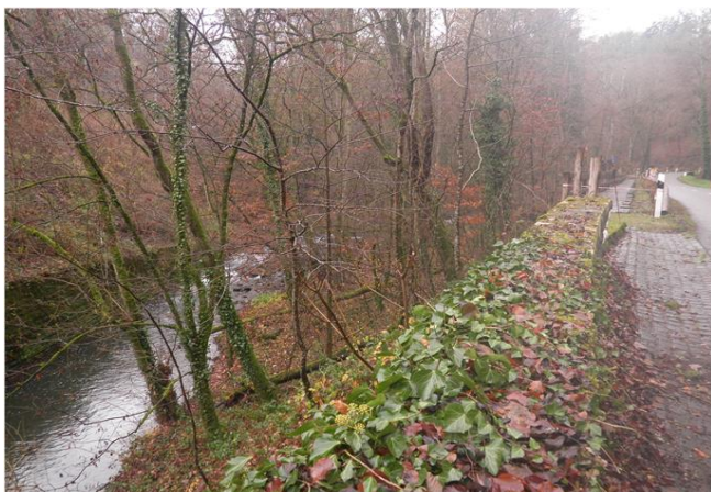
Foto gegen Fließrichtung
