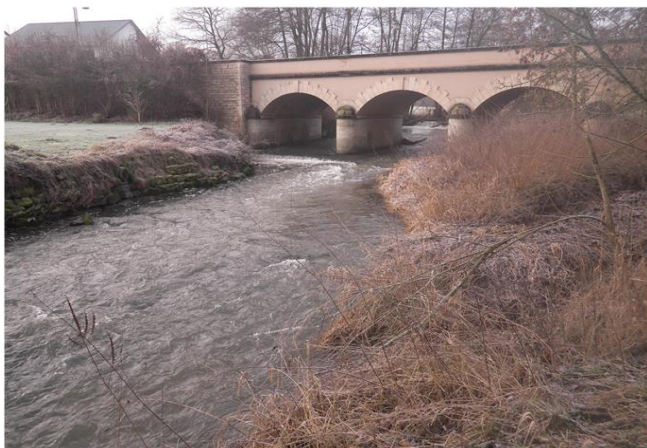
Foto gegen Fließrichtung
