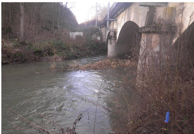
Foto gegen Fließrichtung
