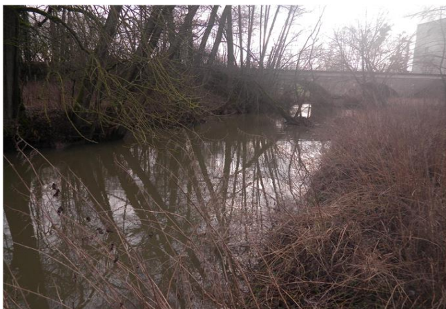
Foto gegen Fließrichtung
