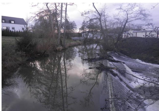
Foto gegen Fließrichtung
