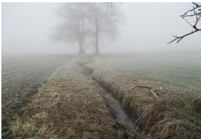
Foto gegen Fließrichtung
