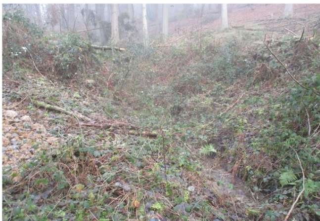
Foto gegen Fließrichtung
