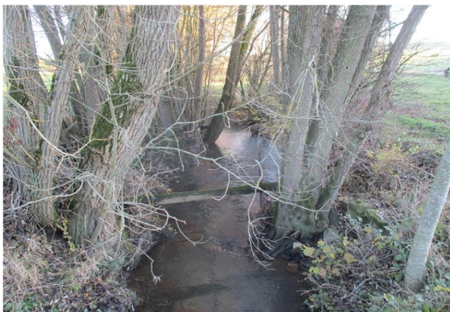
Foto gegen Fließrichtung
