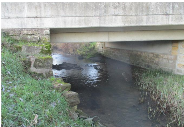
Foto gegen Fließrichtung
