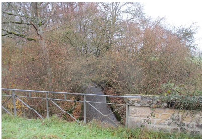
Foto gegen Fließrichtung
