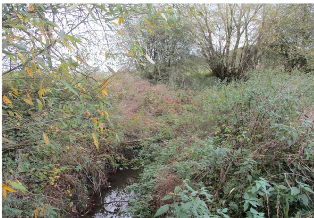
Foto gegen Fließrichtung
