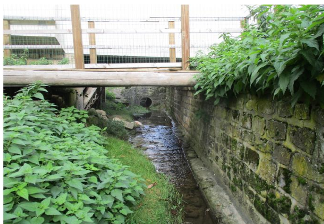
Foto gegen Fließrichtung
