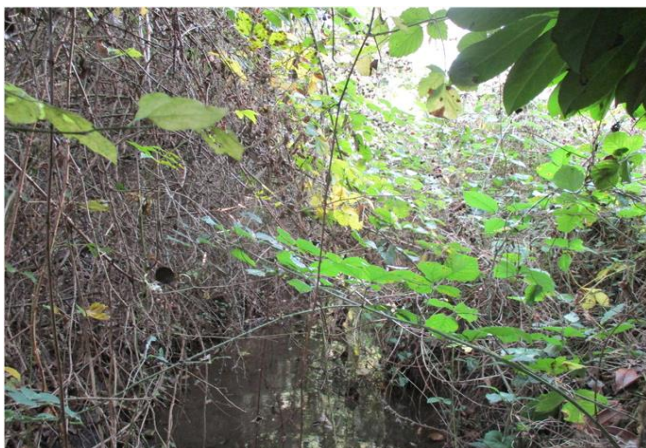
Foto gegen Fließrichtung
