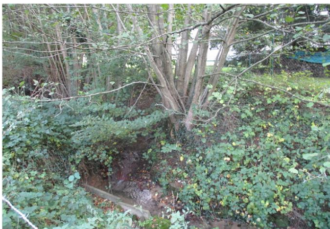
Foto gegen Fließrichtung
