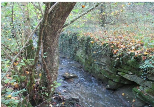
Foto gegen Fließrichtung
