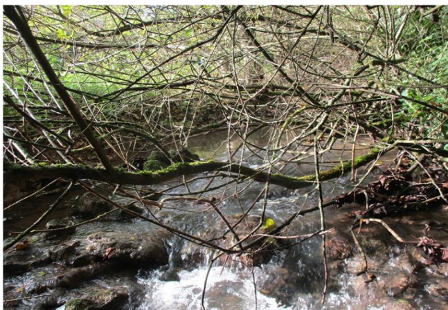
Foto gegen Fließrichtung
