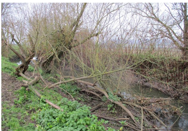
Foto gegen Fließrichtung
