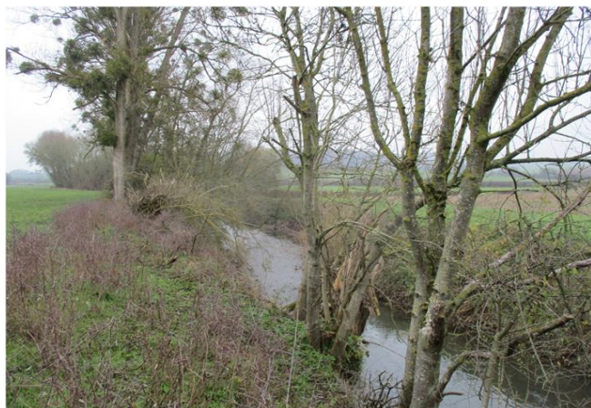
Foto gegen Fließrichtung
