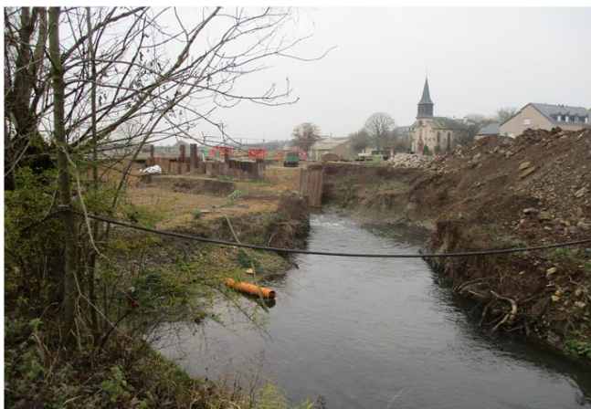
Foto gegen Fließrichtung
