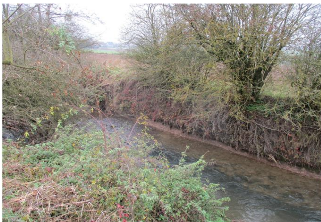
Foto gegen Fließrichtung
