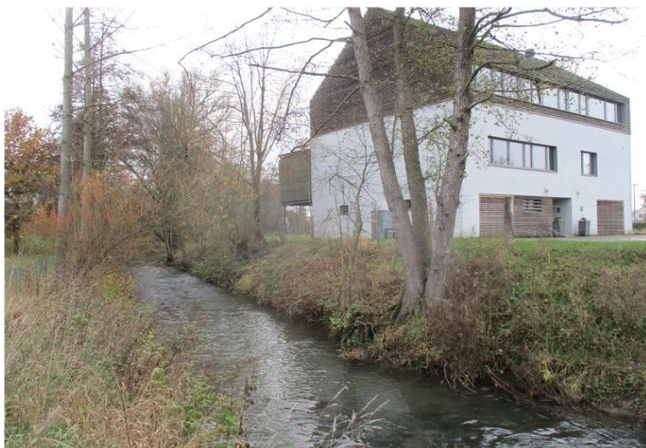
Foto gegen Fließrichtung
