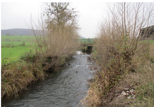
Foto gegen Fließrichtung
