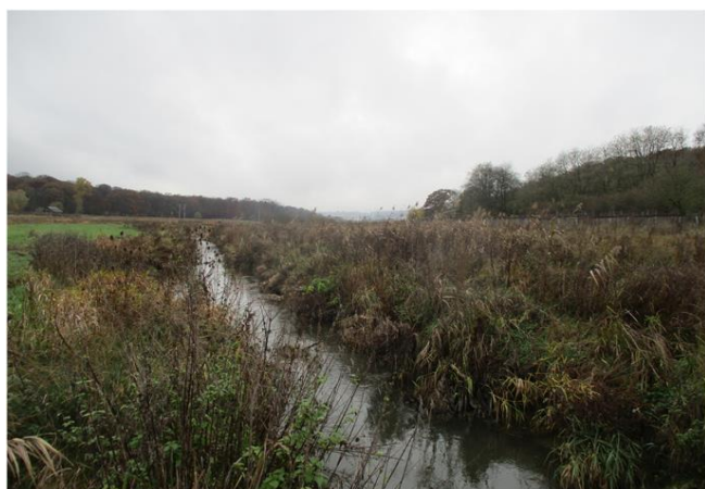
Foto gegen Fließrichtung
