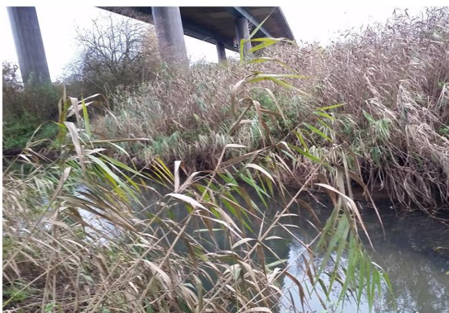
Foto gegen Fließrichtung
