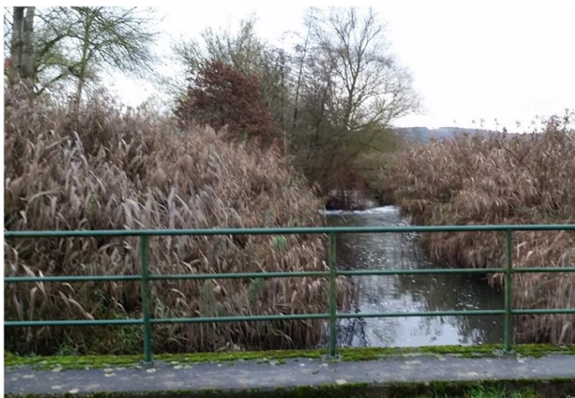
Foto gegen Fließrichtung
