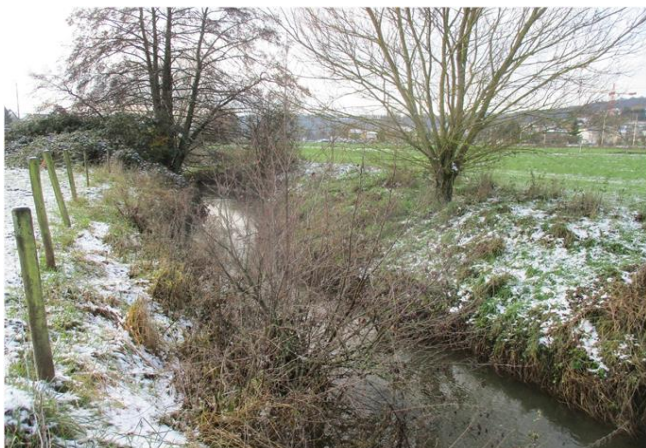
Foto gegen Fließrichtung
