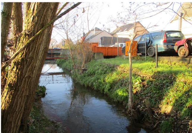
Foto gegen Fließrichtung
