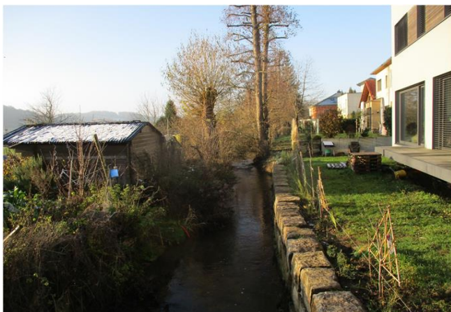
Foto gegen Fließrichtung
