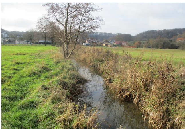
Foto gegen Fließrichtung
