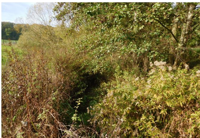
Foto gegen Fließrichtung
