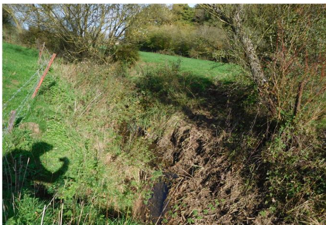
Foto gegen Fließrichtung
