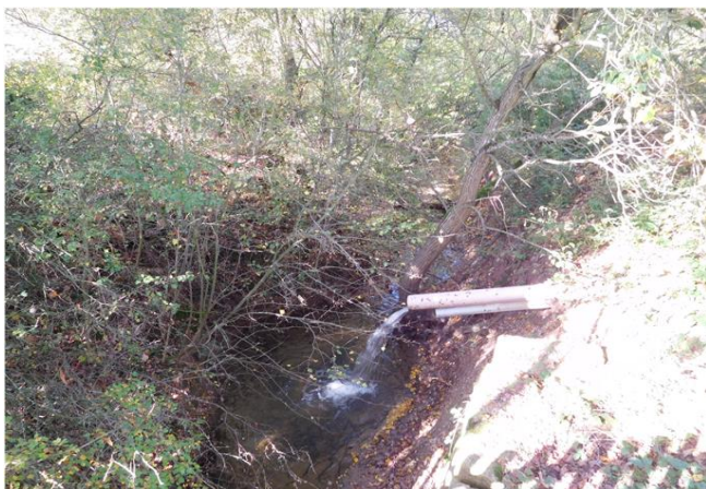
Foto gegen Fließrichtung
