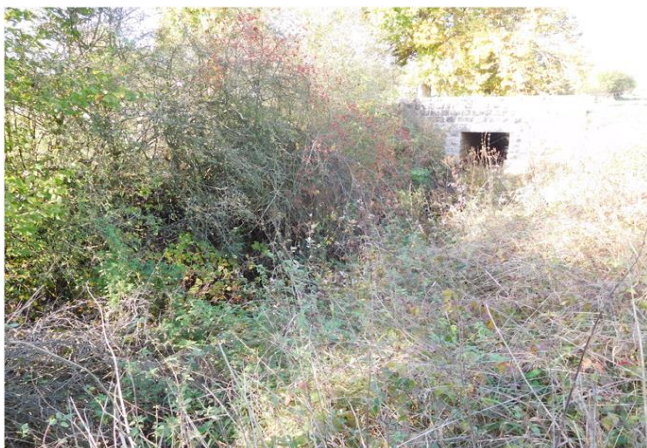
Foto gegen Fließrichtung
