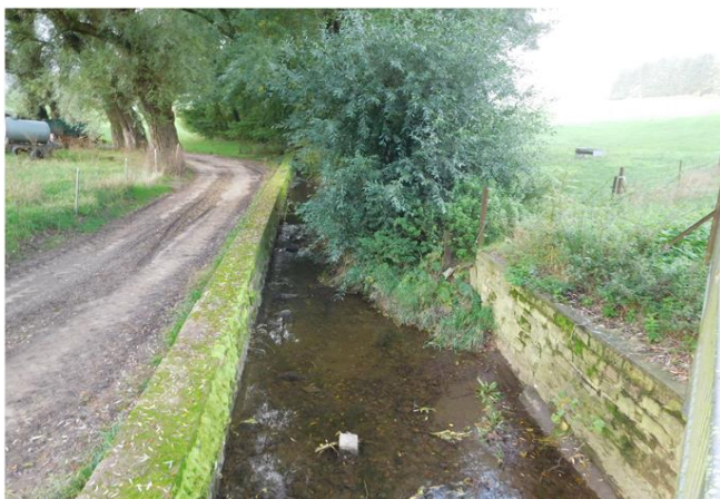
Foto gegen Fließrichtung
