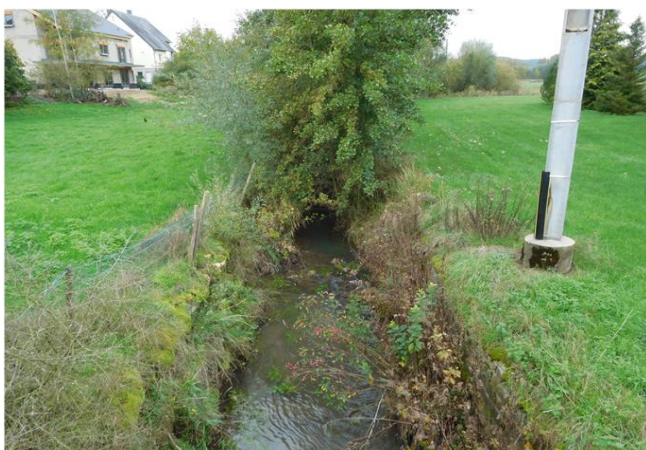
Foto gegen Fließrichtung
