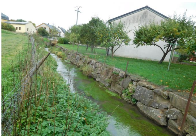
Foto gegen Fließrichtung
