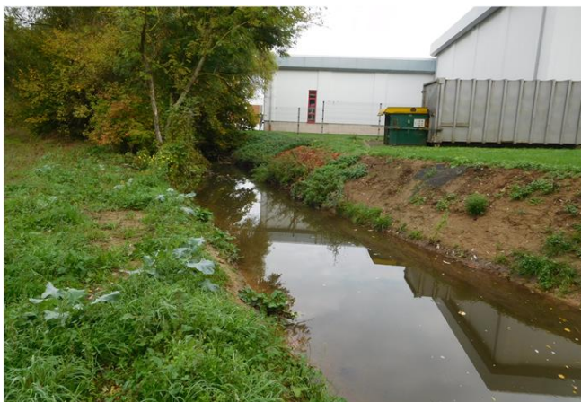
Foto gegen Fließrichtung
