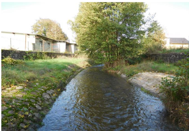
Foto gegen Fließrichtung
